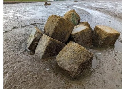
Rifblokken met verbindingskanaal
